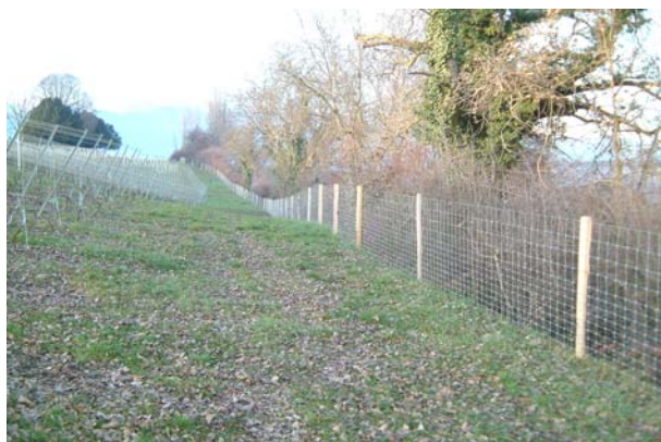
Le remède aux "sangliers-volants": Clôture fixe posée au-dessus de la route du Mandement afin d'éviter les collisions sanglier-voiture. Été 2003, Dardagny GE.
